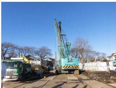
羽村大橋付近・擁壁工事
