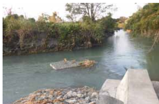
平成 30 年春に復旧工事が完了。再度台風 24 号により被害を受け、用水路の機能が喪失しました。
