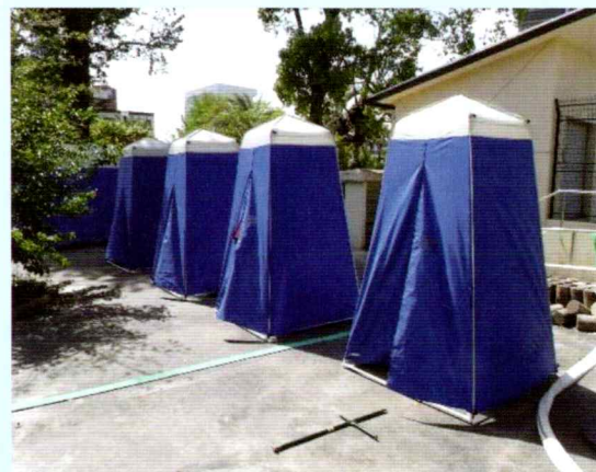
マンホールトイレ (国土交通省ウェブサイトより)
